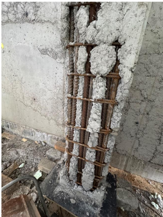
FOTO 3 (Kontrola 17.2.25 SO202 Bunkr odpadu - detail 2 neprobetonovaného sloupu)
