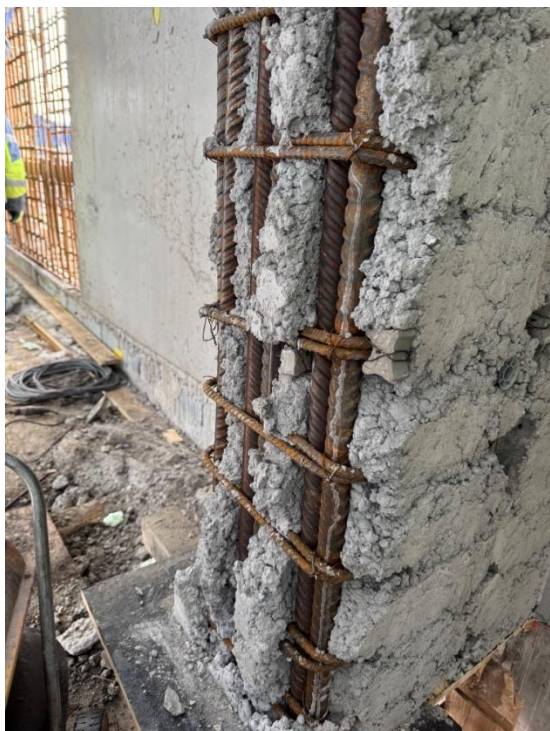
FOTO 3 (Kontrola 17.2.25 SO202 Bunkr odpadu - detail 3 neprobetonovaného sloupu)
